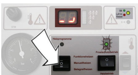
Bild: Programmwahltaster auf „I“ oder „II“ stellen
